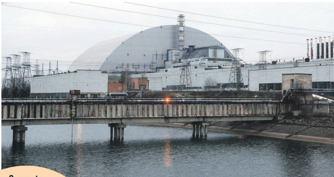
Imagen de archivo del refugio protector sobre los restos de la Unidad 4 del reactor nuclear en la central nuclear de Chernóbil (Ucrania). La explosión de la Unidad 4 de la central nuclear Chernóbil en abril de 1986 se considera como el mayor accidente en la historia de la generación de energía nuclear.
