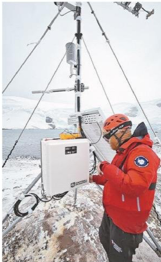
Estación automática registra variables climáticas en tiempo real como temperatura, viento y radiación solar.
