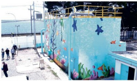
ESTANQUE DE TORMENTA UBICADO EN EL SECTOR PUERTO CHICO DE PUERTO VARAS..
