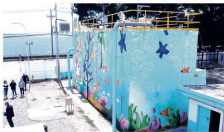
ESTANQUE DE TORMENTA UBICADO EN EL SECTOR PUERTO CHICO DE PUERTO VARAS..
