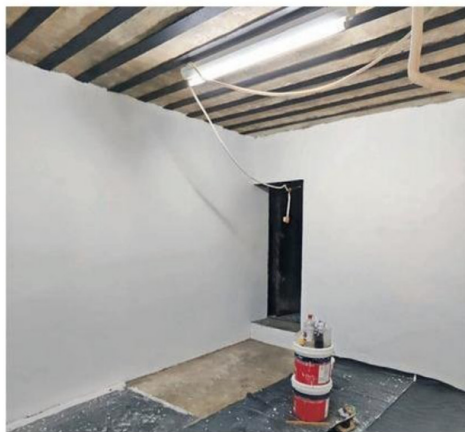
LA BÓVEDA CUENTA CON LADRILLOS REFRACTARIOS.
