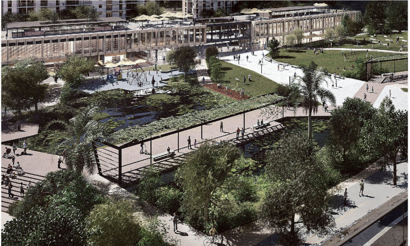
ZONA EN QUE ESTARÁ EMPLAZADO EL FUTURO CENTRO DE CONVENCIONES.
