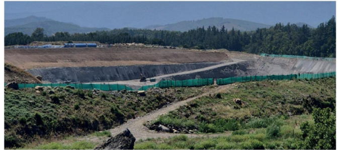
LA EMPRESA IMPLEMENTÓ un refuerzo en el resguardo de sus faenas, con aumento de guardias, mejoras en vigilancia y sistemas como control de accesos y monitoreo tecnológico tras el atentado.
