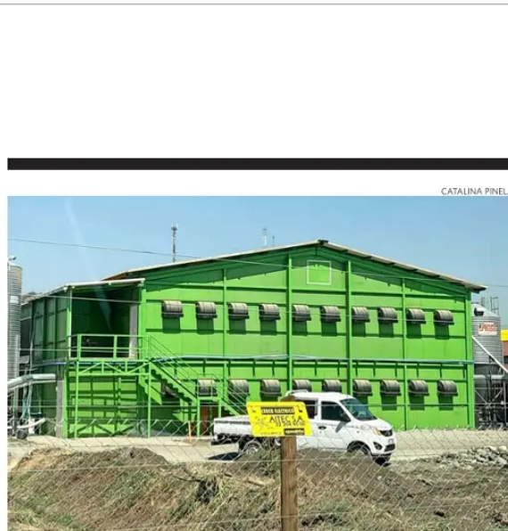
Los galpones tienen extractores para sacar el calor que producen las mismas gallinas.
