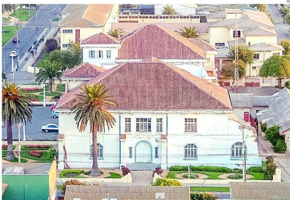
EDIFICIO MUNICIPAL DE SAN ANTONIO, CUYA REMODELACIÓN ESTÁ EN EVALUACIÓN.
