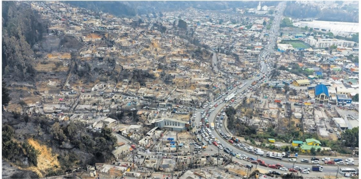
La devastación sufrida en enero pasado, tal como la muestra la imagen tomada a días del incendio, lleva a pensar en nuevas vías de tránsito.
