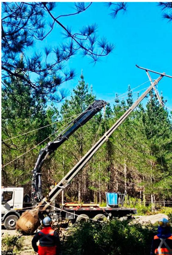
En Charrúa-Chillán, los trabajos se están concentrando en el cambio de estructuras.
