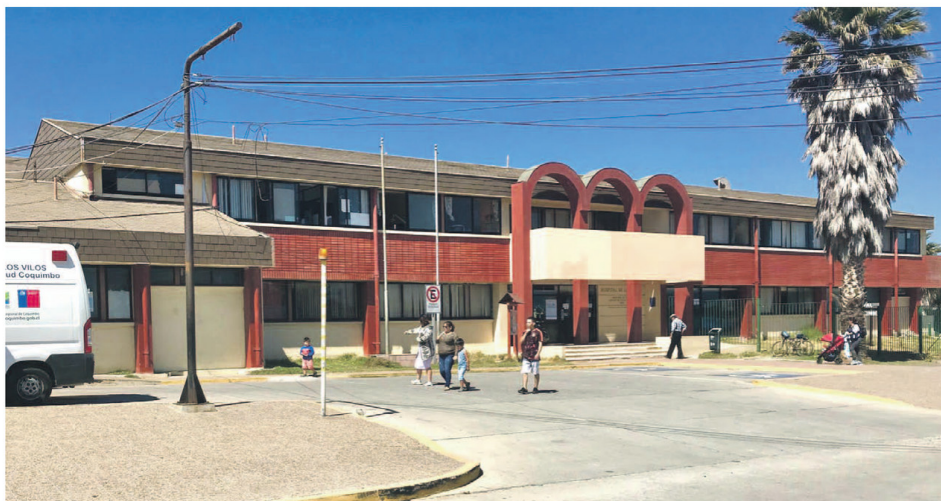
El consejero Hisi detalló una serie de deficiencias estructurales, entre ellas problemas de climatización, redes de aire, baños e insumos médicos.
