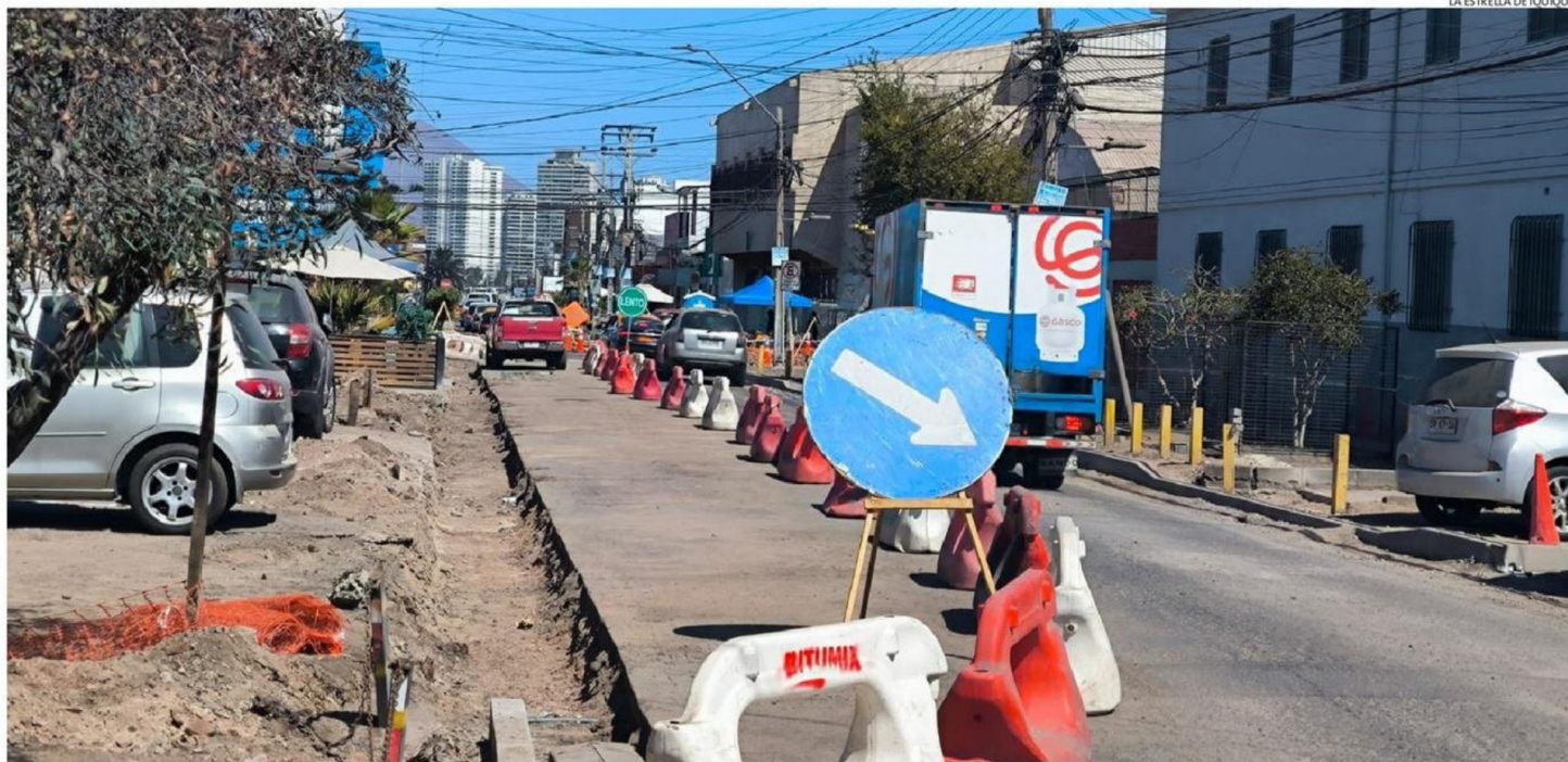
ACTUALMENTE SE EJECUTAN TRABAJOS EN EL SECTOR DE CALLE BARROS ARANA ENTRE RIQUELME Y JOSÉ JOAQUÍN PÉREZ.
