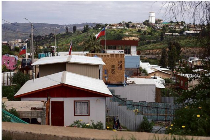
4 CASAS EN PROCESO DE RECEPCIÓN (DOM) Y 52 CON 93% DE EJECUCIÓN: ENTIDAD PATROCINANTE.
