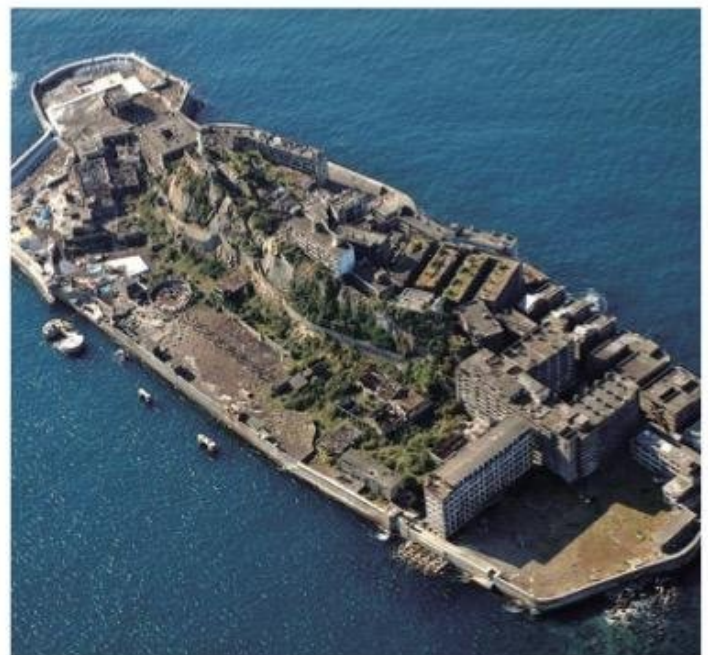
En su apogeo en los años 50, Hashima llegó a albergar a casi seis mil habitantes y numerosos edificios e instalaciones. La decadencia de Hashima comenzó con el agotamiento de la veta de carbón y el auge de la industria petrolera en Japón.
