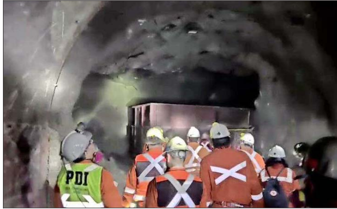
La Fiscalía Regional de O'Higgins encabeza la indagatoria en torno al derrumbe y otro incidente en la mina El Teniente.
