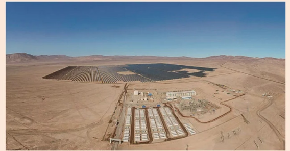
Servicio de Owner's Engineering para proyecto BESS Tamaya, Tocopilla (ENGIE). Capacidad: 68 MW / 418 MWh (152 contenedores de baterías).
