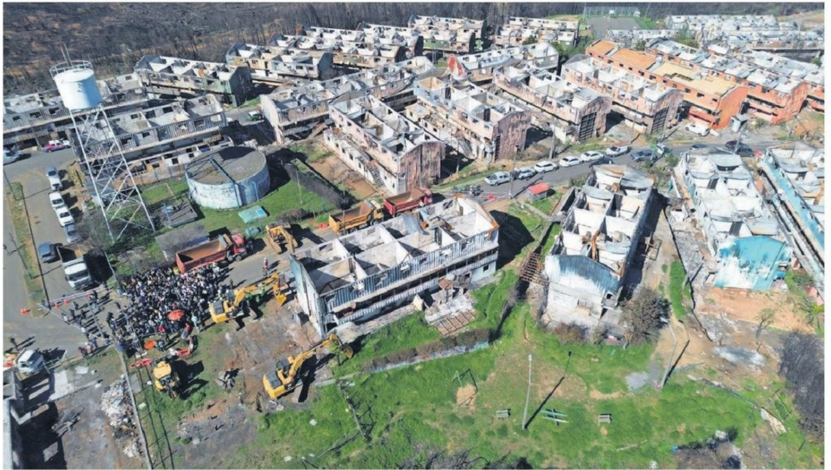
La semana pasada comenzó el proceso de demolición de los block de Ríos de Chile en Lirquén, una de las zonas más siniestradas tras los incendios de enero.
