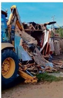
UNA RETROEXCAVADORA DESTRUYÓ LAS PRECARIAS VIVIENDAS
