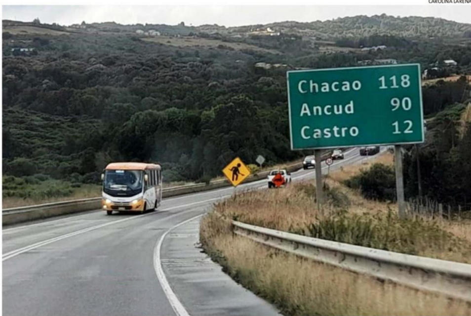
EL PRIMER TRAMO DEL MEJORAMIENTO DE LA PANAMERICANA CONSIDERA DESDE CHACAO A CHONCHI.
