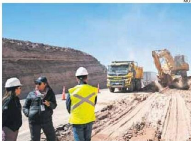
OBRAS MEJORARÁN LOS ESTÁNDARES DE LA RUTA 23CH.
