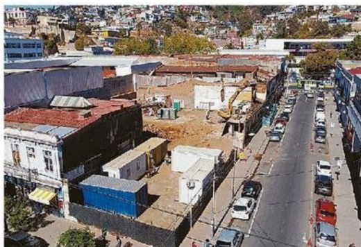
DEMOLICIÓN PARA DAR PASO A UN PROYECTO DE VIVIENDAS SOCIALES.
