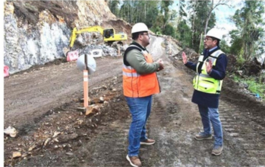
EL SEREMI DEL MOP REALIZÓ UNA VISITA INSPECTIVA A LOS TRABAJOS.
