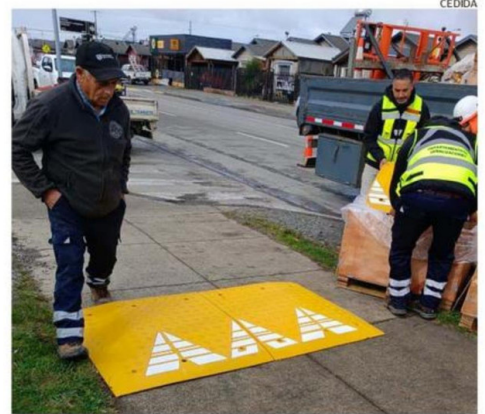
LOS REDUCTORES DE VELOCIDAD YA ESTÁN INSTALADOS.
