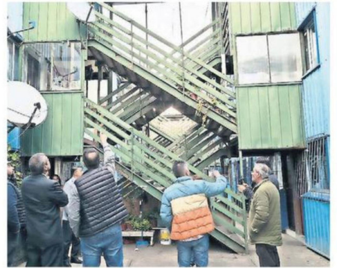
LAS ESCALERAS SERÁN REPARADAS EN LOS EDIFICIOS
