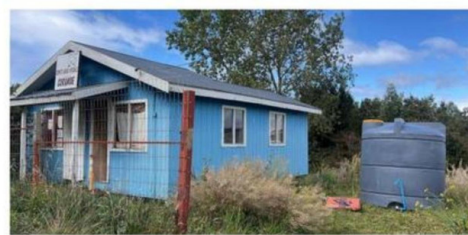
EN EL SECTOR DE LA EMERGENCIA SE INSTALARON ESTANQUES.
