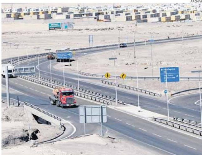
LA NUEVA CIRCUNVALACIÓN CONTEMPLA 24,6 KILÓMETROS Y BORDEARÁ EL SECTOR ORIENTE DE CALAMA.
