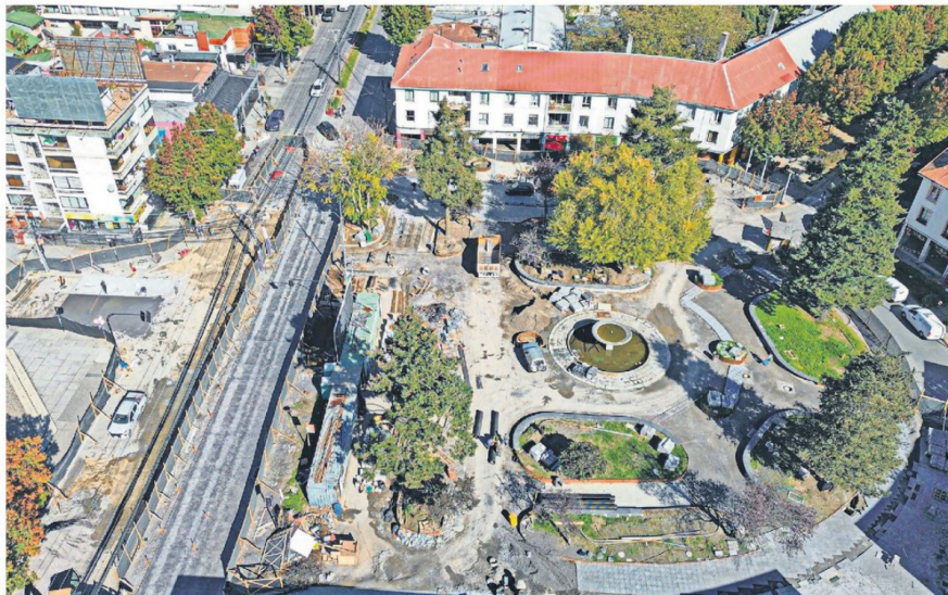
Vista aérea de los trabajos en Plaza Perú. La demora genera varios dolores de cabeza en los vecinos del sector.
