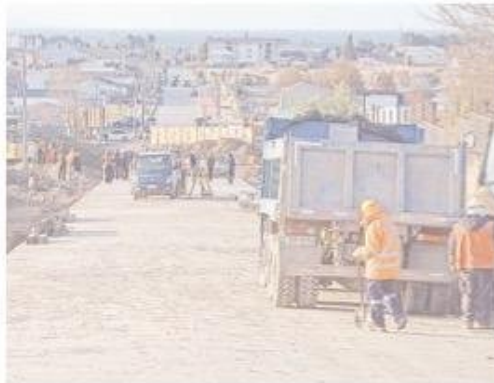
Una vista de cómo está quedando la pavimentación de la calle Ovejero, de cerro a playa.
