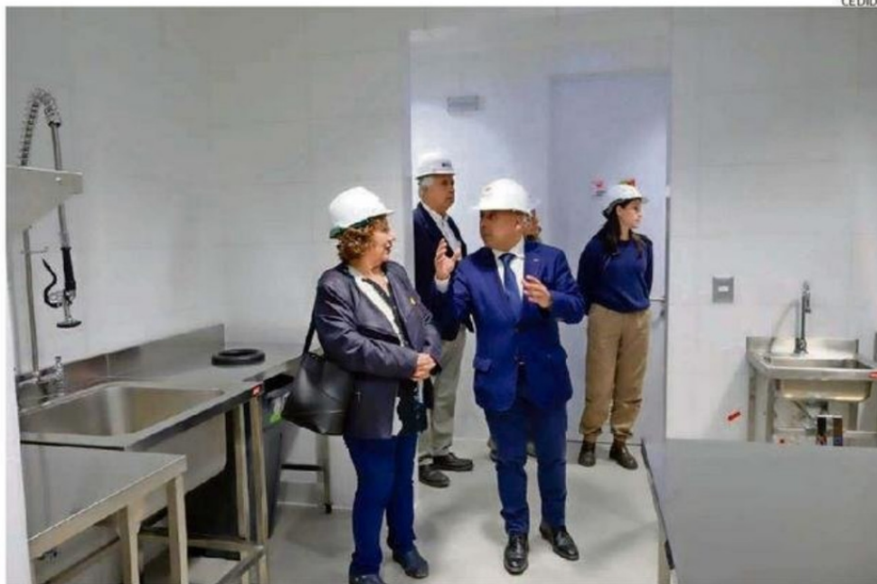
ACTUALMENTE, LABORES SE CONCENTRAN EN TRABAJOS DE TERMINACIONES.
