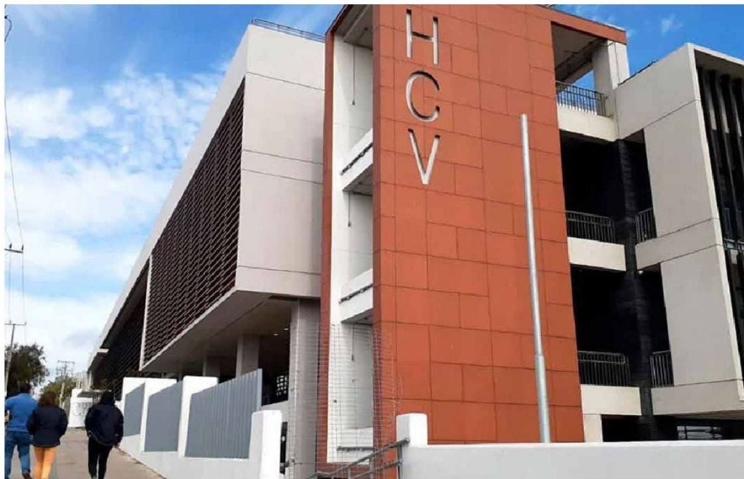
► Imagen de una ampliación del Hospital Claudio Vicuña de San Antonio.
