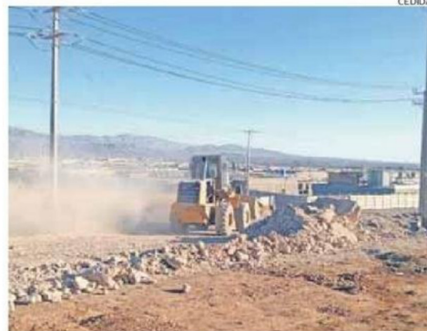
LOS ARREGLOS SE EFECTUARON EN CERCA DE 5 KILÓMETROS DE CAMINO.
