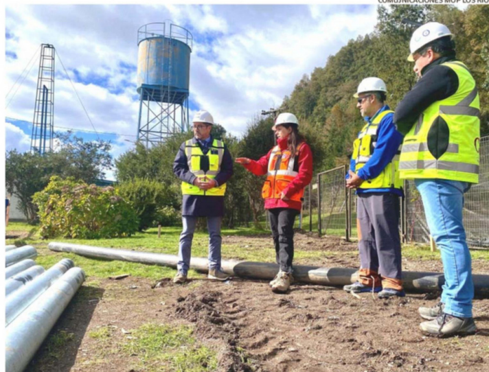
EL SEREMI DE OBRAS PÚBLICAS, ULISES RIVERA, REALIZÓ UNA VISITA INSPECTIVA A LAS OBRAS EN PANGUIPULLI.
