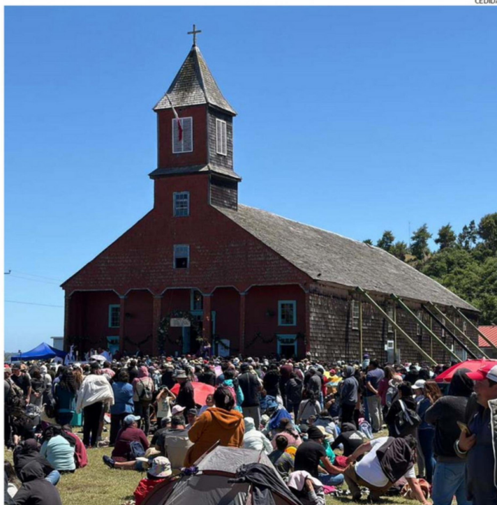
IGLESIA PATRIMONIAL JESÚS NAZARENO DE CAGUACH ESTÁ EN PROCESO DE OBRAS DE EMERGENCIAS
