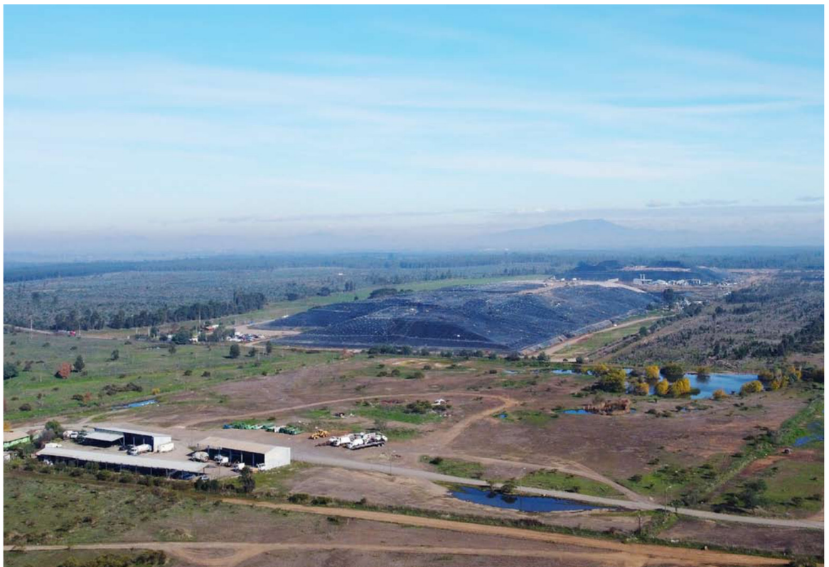
El proyecto se emplazará en el lugar donde operó el relleno Quilmo, de Enasa.
