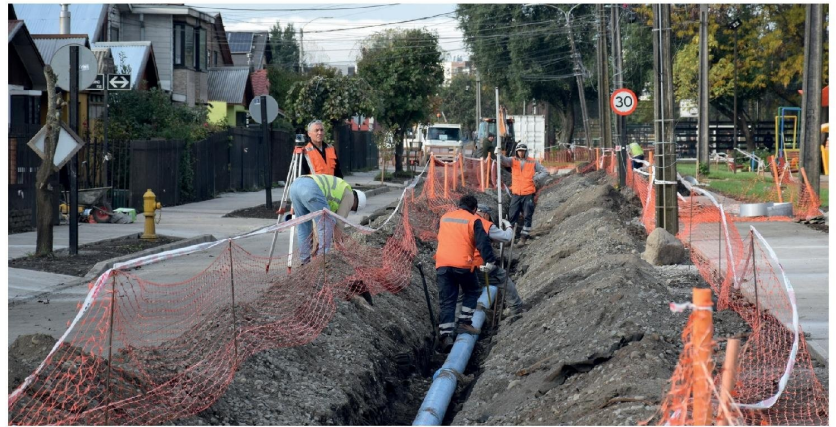
AVANZAN LAS FAENAS de hormigonado en Avenida Costanera Quilque Norte, obra que busca mejorar la conectividad y seguridad vial del sector.
