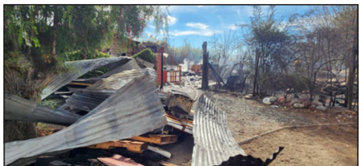
El fuego avanzó rápidamente hacia las viviendas.
