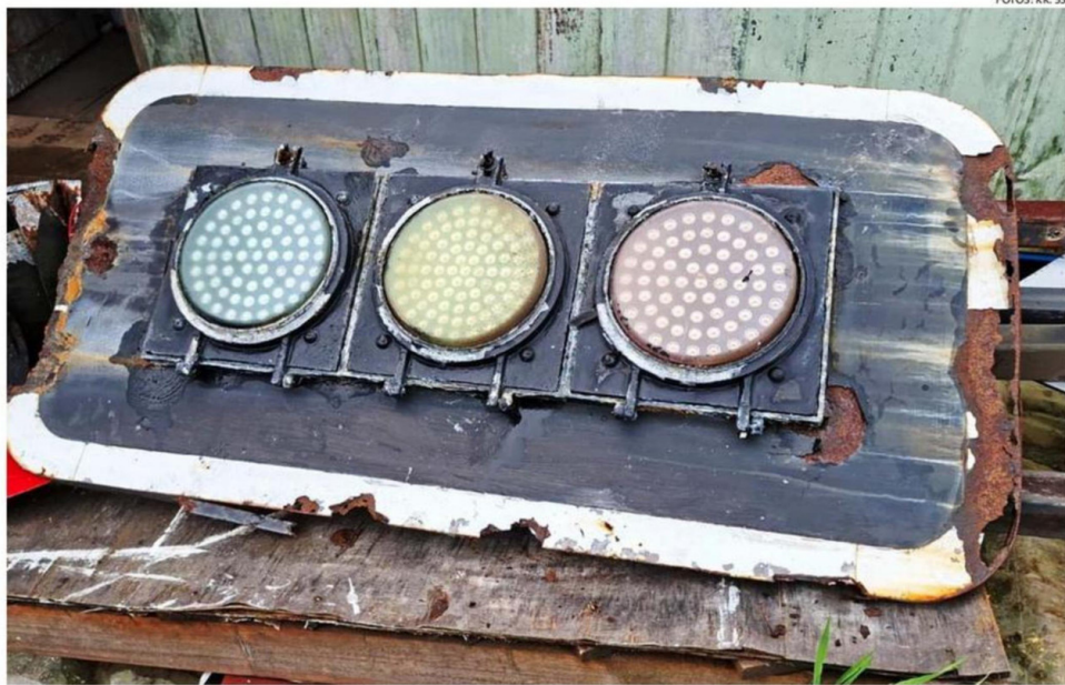
ESTA SEÑALÉTICA ELÉCTRICA QUE SE DESPRENDIÓ POR EL VIENTO MUESTRA EVIDENTE OXIDACIÓN.
