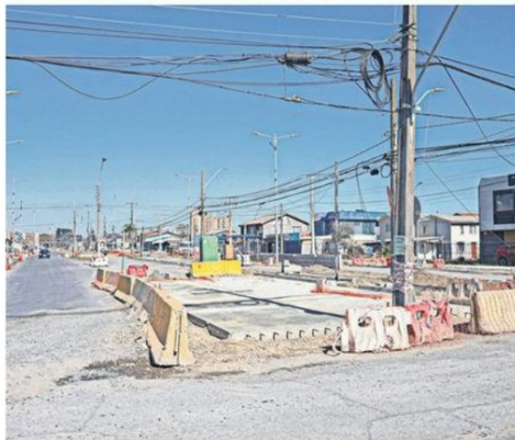
En el Eje Colón, las obras están en un 60% de avance.
