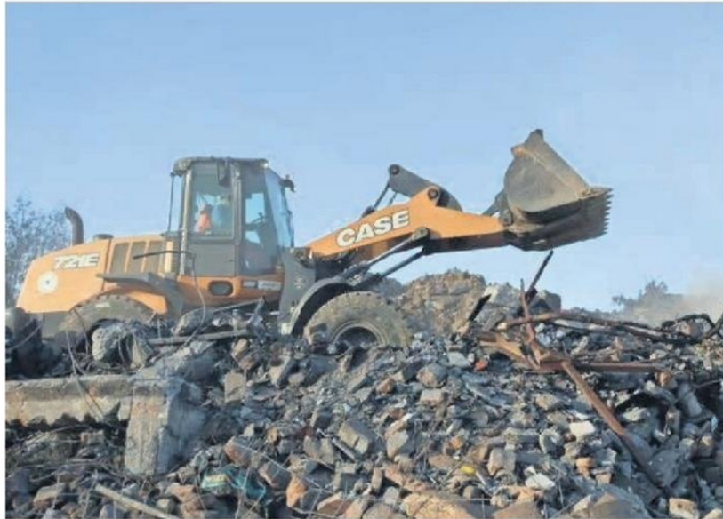
Una de las tareas más demandantes ha sido la remoción de escombros en Lirquén.
