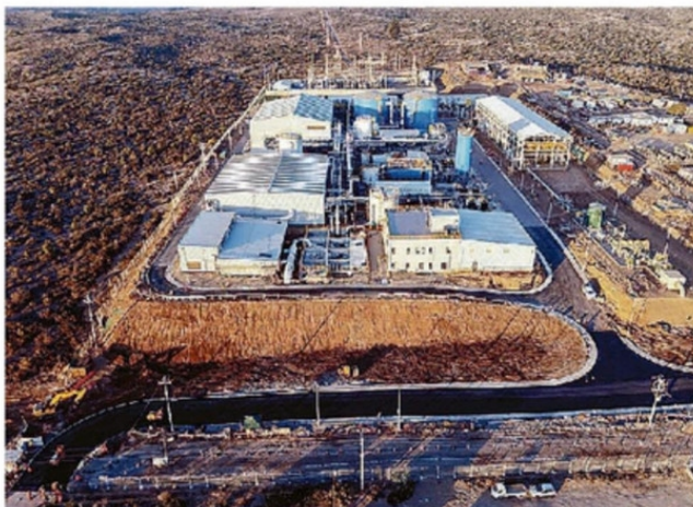
MODIFICACIÓN OPTIMIZA LA INFRAESTRUCTURA ORIGINAL.
