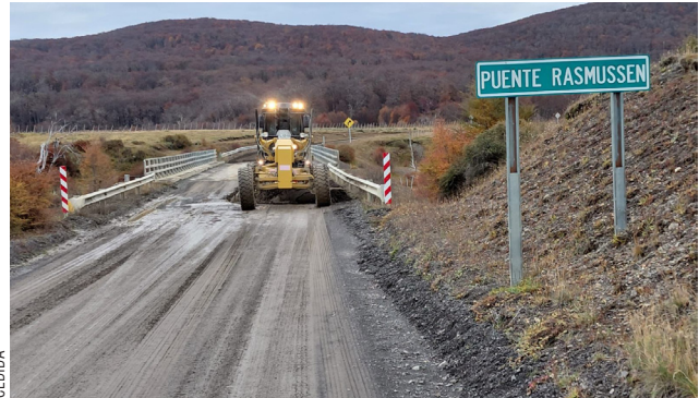
Ruta Y-85 Puente Rasmussen, Km 159.
