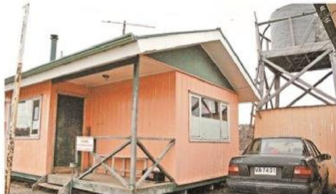
La desvencijada antigua Posta de Salud de Pampa Guanaco quedó obsoleta hace tiempo, por lo que la Municipalidad de Timaukel postuló a un recinto más amplio y moderno, con un área de 320 m 2 , cuya construcción partirá en diciembre de este año.
