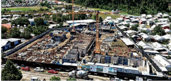
Las obras tienen un avance de 23,81% al 28 de abril de este año.
