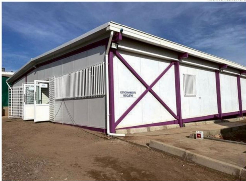
DE ACUERDO AL SSVQ, EL CENTRO DE SALUD OPERARÍA EN EL SEGUNDO SEMESTRE DE 2026
