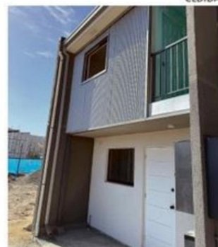
OBRAS DE MÁS DE MEDIO CENTENAR DE VIVIENDAS DETENIDAS.
