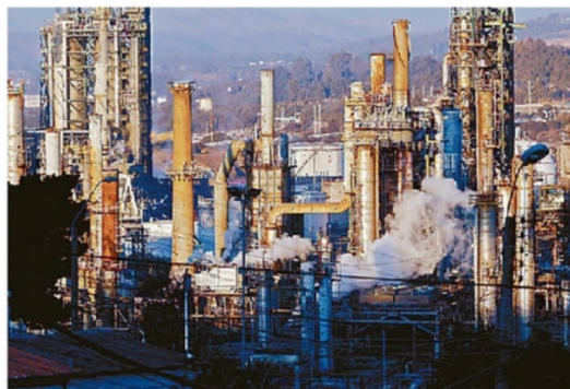
IRREGULARIDADES AFECTAN A LA REFINERÍA ACONCAGUA, EN CONCÓN.
