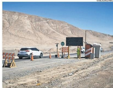
SE LLAMÓ A LA PACIENCIA EN LOS HORARIOS DE TRONADURAS.
