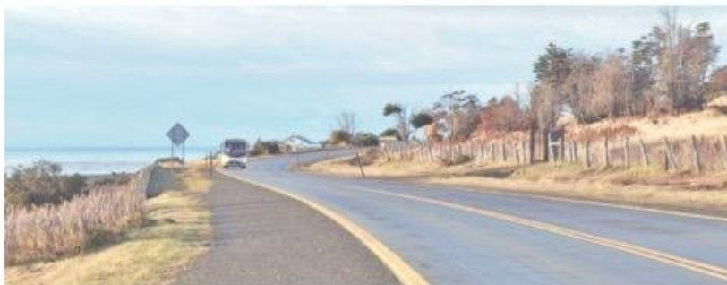
La curva que se divisa al fondo de la imagen, a la altura del km 42 Sur, conecta con el camino que conduce al Cerro Campana, donde se ofrecieron terrenos a la venta, cuyas compras terminaron en tribunales.
