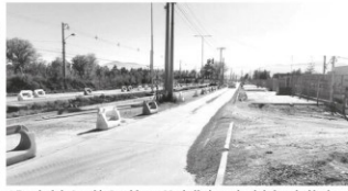
Estado de la Avenida Sanchina en Machalí, al exterior de la instalación de faenas de Tapasa.
